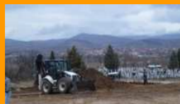
Започна изградбата на градска капела
